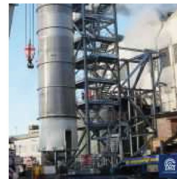
Montaż wyparki CORDONNIER SA
